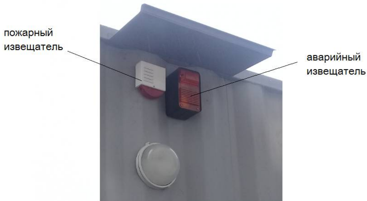
Рисунок 2.1 – Пример расположения извещателей
